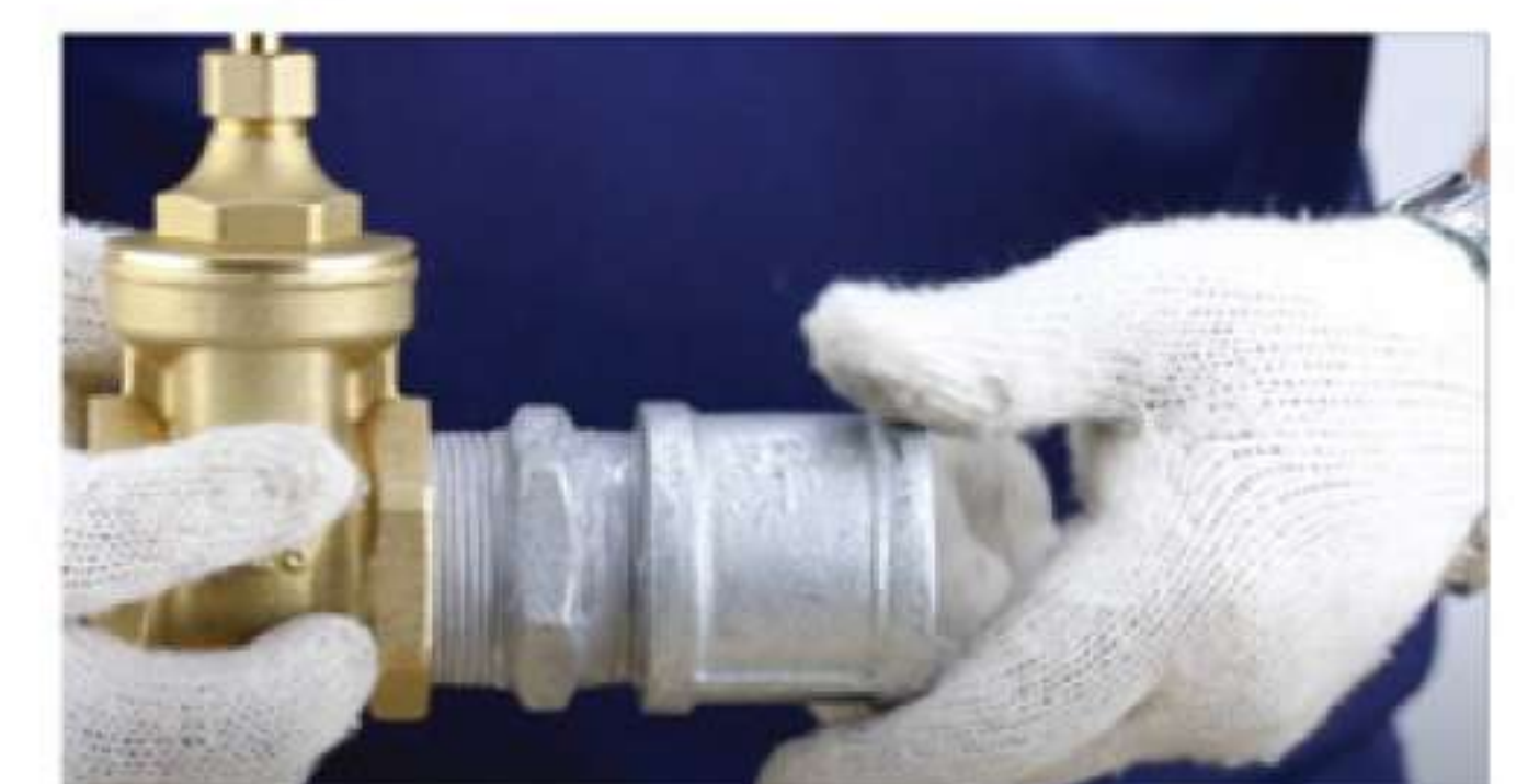
7. ขันข้อต่อตรงเข้ากับข้อต่อนิปปเปิ้ล โดยไม่ต้องรอให้เออร์เมสซีล 55 แห้ง
