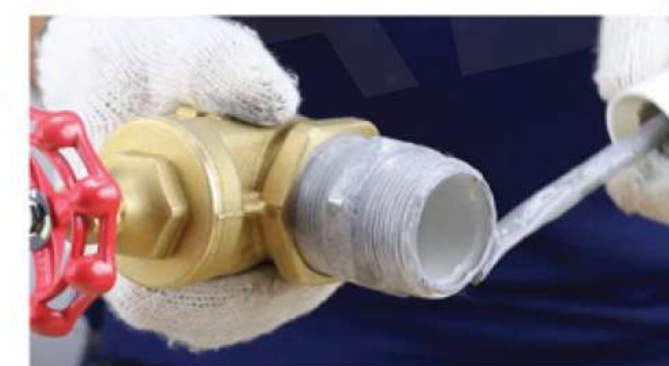
6. ทาเออร์เมสซีล 55 กับบริเวณที่พันเกลียวอีกด้านของข้อต่อนิปปเปิ้ล
